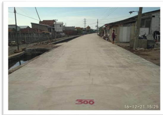
Gambar 3.2 Peningkatan Jalan Sriwulan – Sayung Kec. Sayung Kab. Demak
