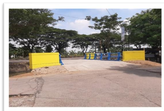
Gambar 3.3 Pembangunan Jembatan Desa Cangkring – Wonorejo Kecamatan Karanganyar
