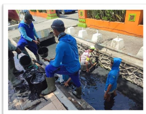
Gambar 3.5 Rehabilitasi saluran drainase perkotaan
