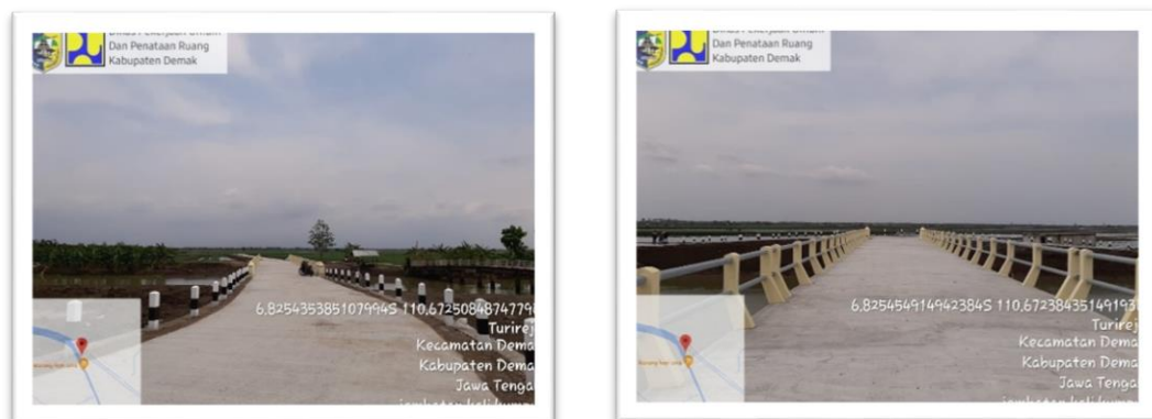
Gambar 3. 3 Pembangunan Jalan dan Jembatan
