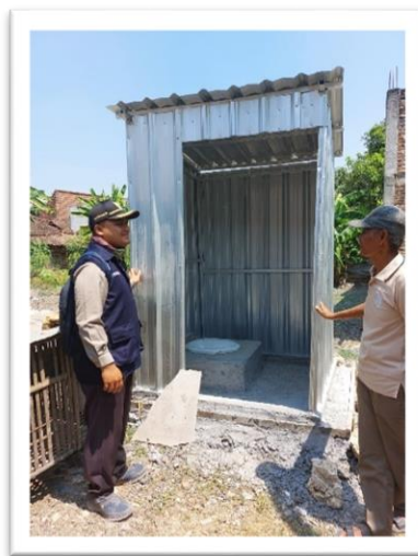
Gambar 3.2 Pembangunan Tangki Septik Skala Individual
