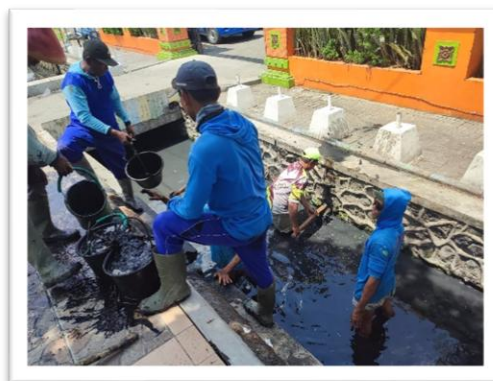
Gambar 3.5 Rehabilitasi saluran drainase perkotaan
