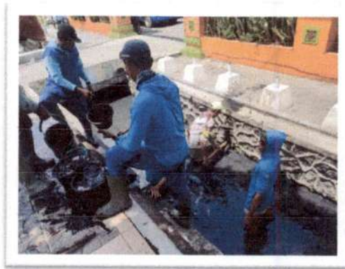
Gambar 3.5 Rehabilitasi saluran drainase perkotaan
