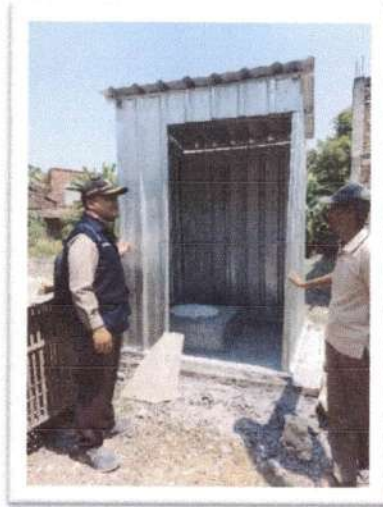
Gambar 3.2 Pembangunan Tangki Septik Skala Individual
